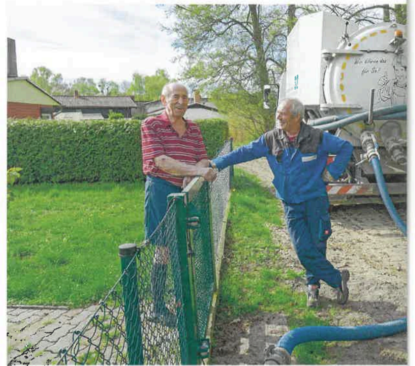
Kleiner Plausch am Gartenzaun während das Schmutzwasser in den Laster läuft.
