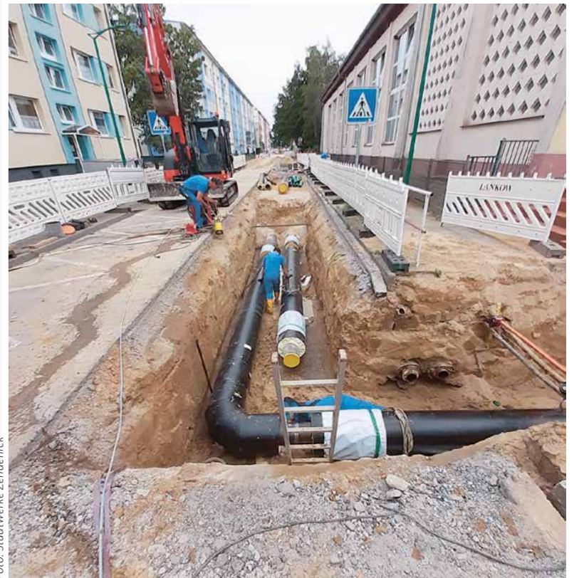
Umbundungstag von der alten auf die neue Fernwärmeleitung.
