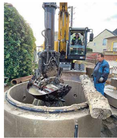
Ring für Ring entsteht der neue Schacht für das Ersatzpumpwerk.
