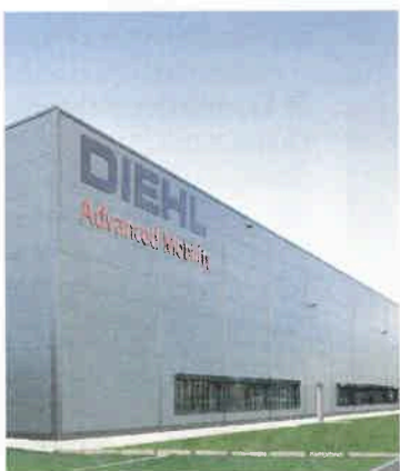
Die Produktionshalle in Zehdenick: Hier werden die Zellkontaktiersysteme hergestellt. Fotos: DAM
