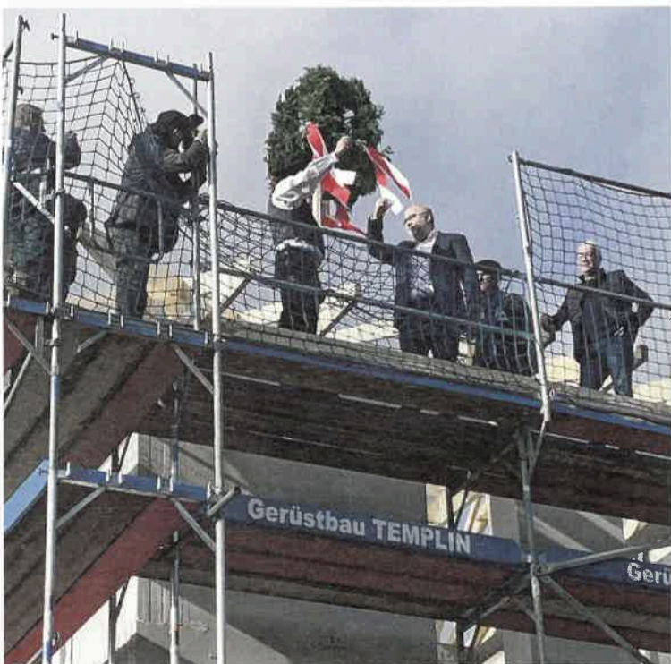
Zimmermann Jens Suchland hält den Richtspruch und dankt allen beteiligten Bauleuten.
