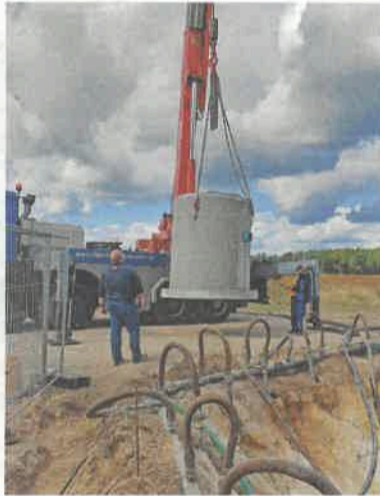
Hier schweben neun Tonnen am Kran.
