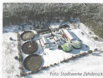
Foto: Stadtwerke Zehdenick
