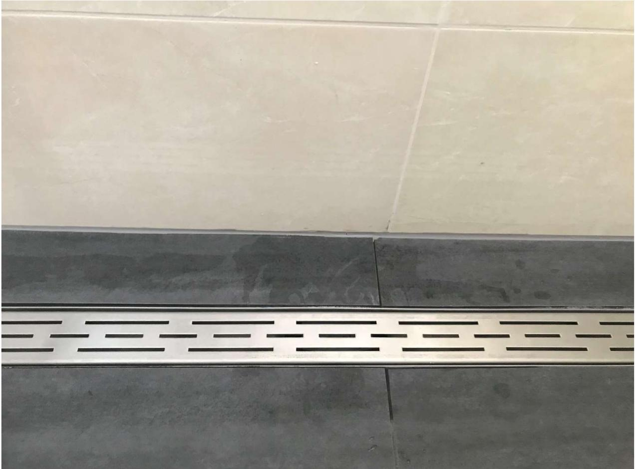
Füllen Sie etwas Wasser in die Rinne ein. Im Siphon sollte immer etwas Wasser stehen. Das Wasser verhindert die Bildung von unangenehmen Gerüchen und verschließt den Abfluss luftdicht (Traps).
