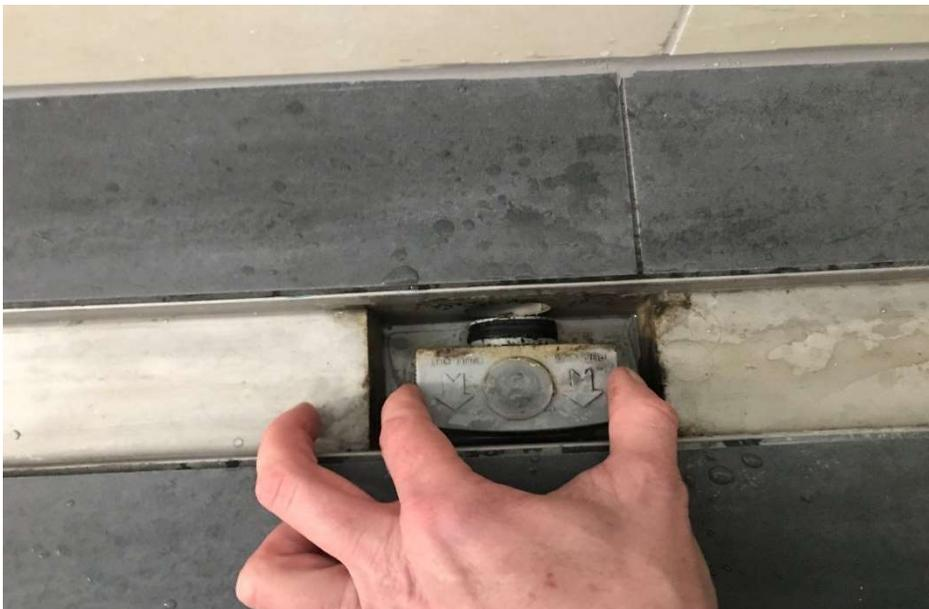
Ziehen Sie den Geruchsverschluss mit leichten Wackelbewegungen nach hinten aus dem Ablaufrohr. Das Wasser im Siphon läuft nun ab.
