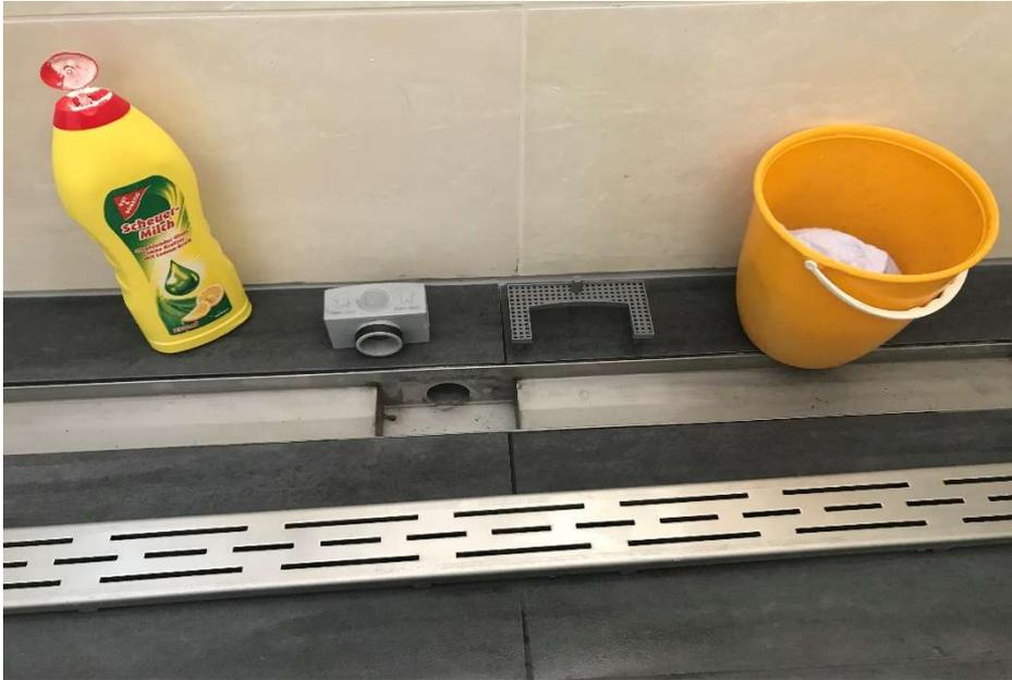
Reinigen Sie den Grobfilter und den Geruchsverschluss. Sie können diese Teile nicht in der Spülmaschine waschen.
