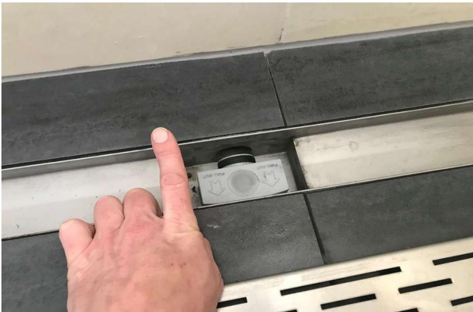
Drücken Sie den gereinigten Geruchsverschluss bis zum Anschlag in das Ablaufrohr.
