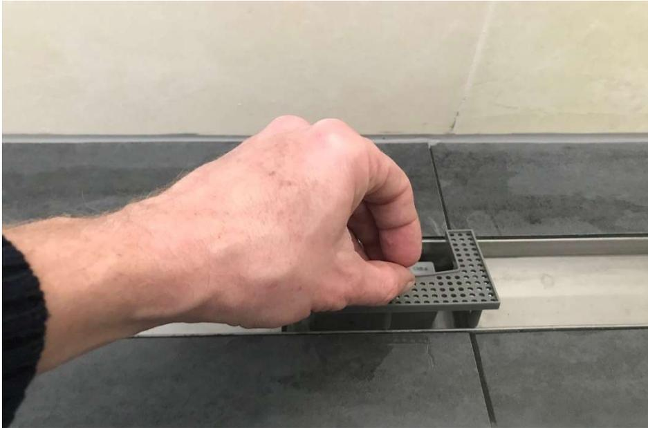
Setzen Sie den Grobfilter (Sieb) von oben in den Siphon ein.
