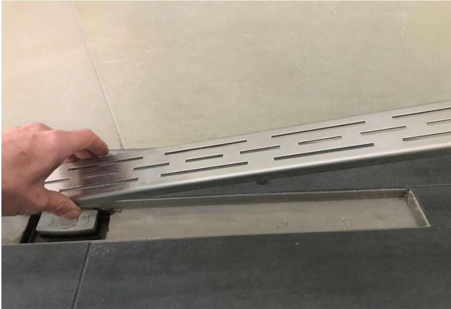
Entfernen Sie die Abdeckung aus Edelstahl. Nun sehen Sie ein Sieb aus grauem PVC (Grobfilter).
